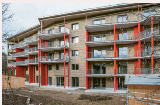
Erdbebengerecht erstellte Wohnüberbauung auf dem Hanro-Areal in Liestal (BL). Bild: Peter Kupferschmied | EPSD
