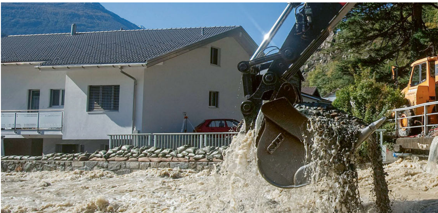
Ausbaggern des Flussbetts der Lonza in Gampel-Steg (VS) nach den Überschwemmungen im Oktober 2011
